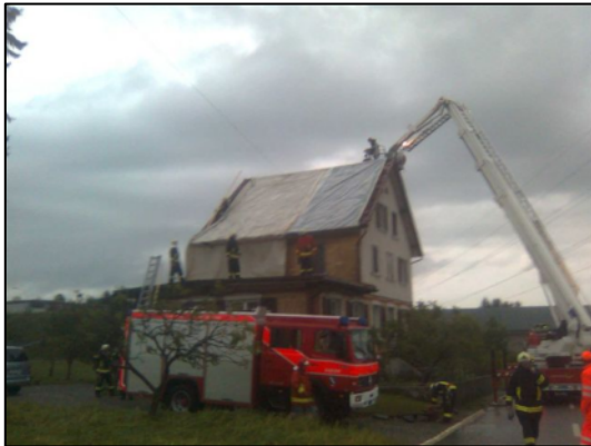
Hagelschaden: 26. Mai 2009 Erstellen von einem Notdach
