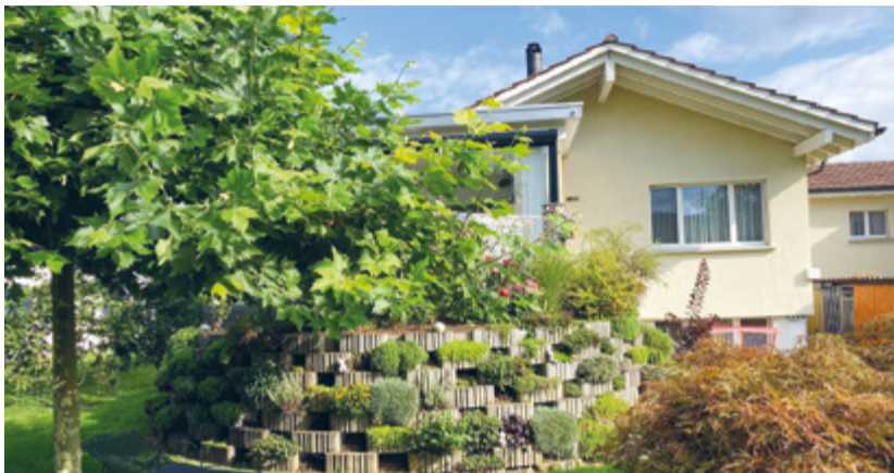
Das energetisch modernisierte EFH der Familie Teucher in Sirmach.
