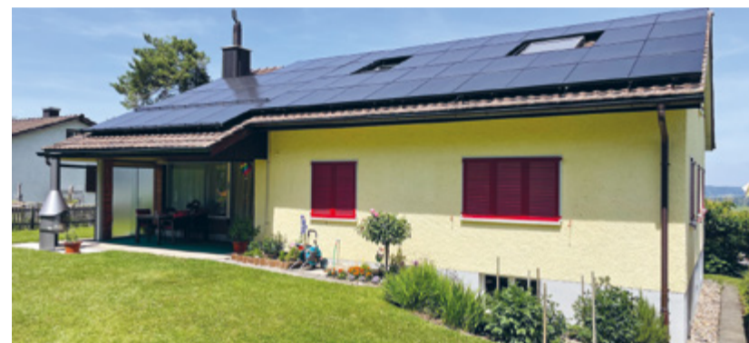
80.4 m 2 Solarpanel liefern eine Spitzenleistung von 15 KW.
