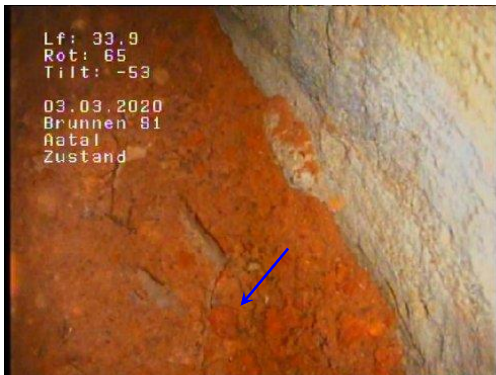
Bild 22: Tiefe 33,9 m 1000-mm-Stahl-Sumpfrohr Die Auflandung wurde in 34,1 m Tiefe angetroffen. Die Auflandung besteht aus herabgesunkenen Eisenverockerungsflocken.
