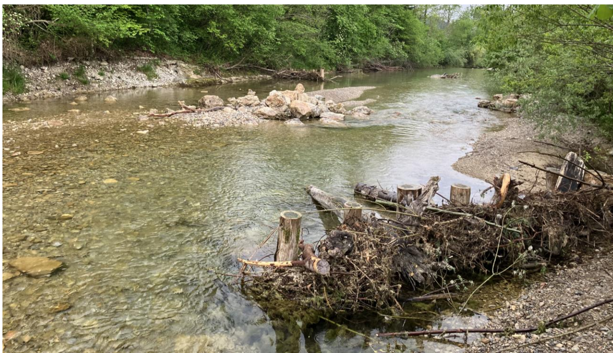
Abbildung 16: Beispiel einer inklinen Totholzstruktur (Totholzrechen, Pfahlstruktur) an der Töss bei Rikon. Blick in Strömungsrichtung. (Bild: NRP Ingenieure AG 01.05.2025)
